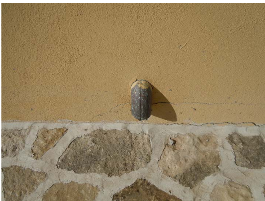
Vista 10: Particolare scarico acque meteoriche
