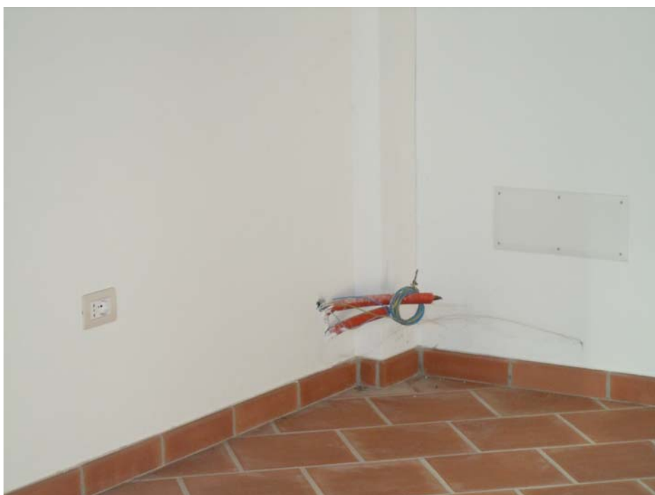
Vista 14: Predisposizione impianto di climatizzazione
