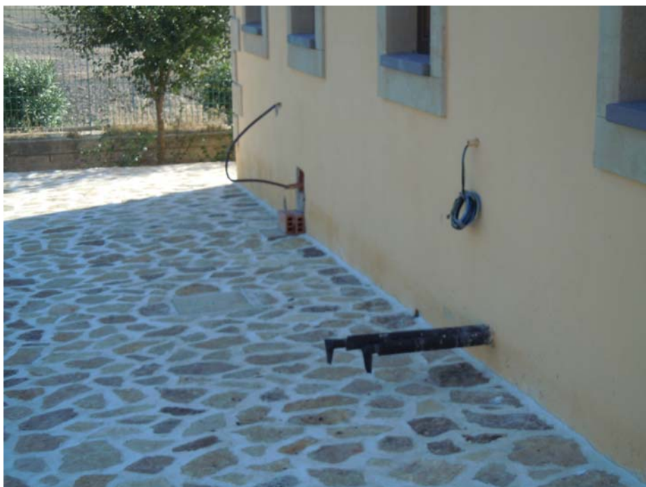
Vista 9: Predisposizioni idrico e climatizzazione
