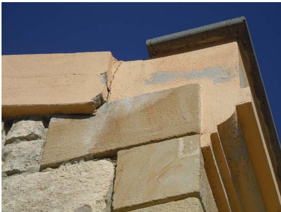
Vista 11: Particolare lesione cornicione
